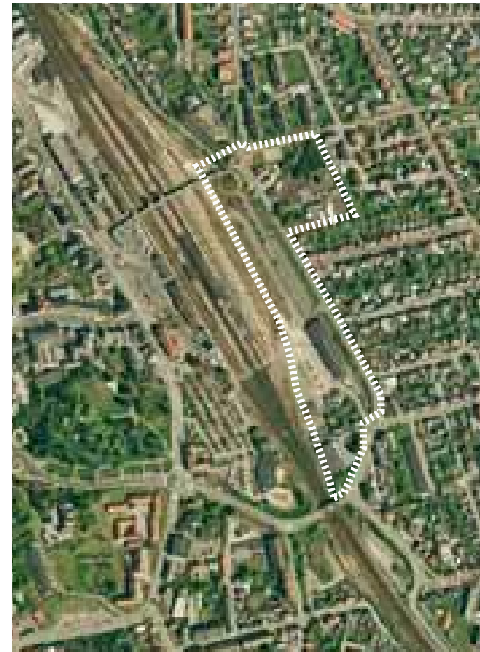
Luftfoto af projektområde ved stationen/nord.
